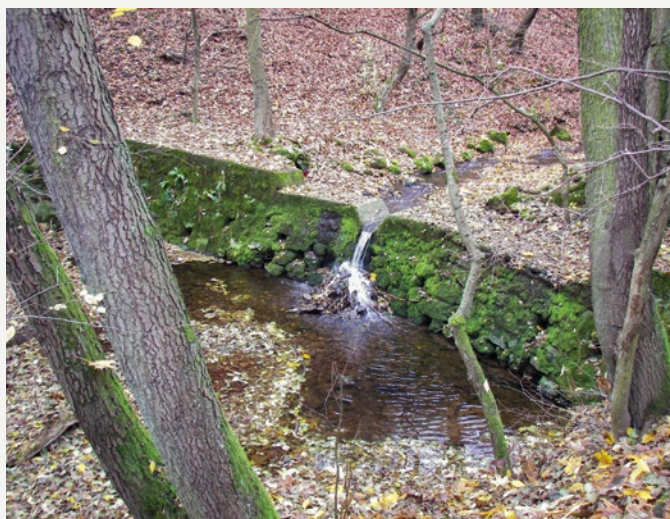
Fenéklépcső (egykori hordalékfogó gát) Szentendre közelében a Bükkös-patakon (©KUM)
