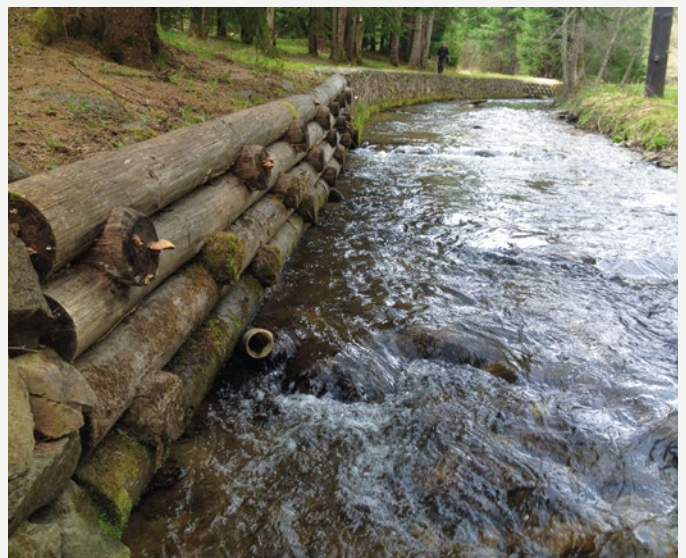
Part stabilizálása faanyagú művel (©KáM)
