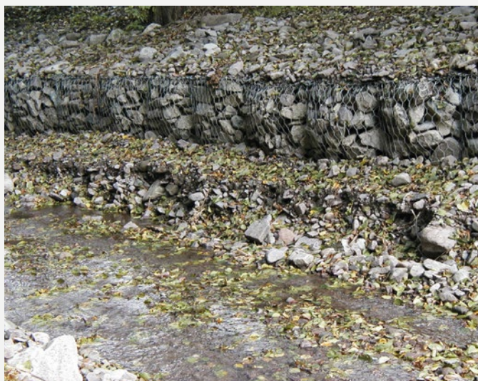
Helyszíni anyagból készült gabion-partvédő fal (©KP)
