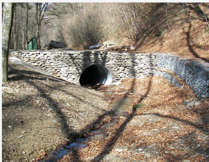
A Kőszegi-hegység Hámori útján újjáépített áteresztő (©PJ)
