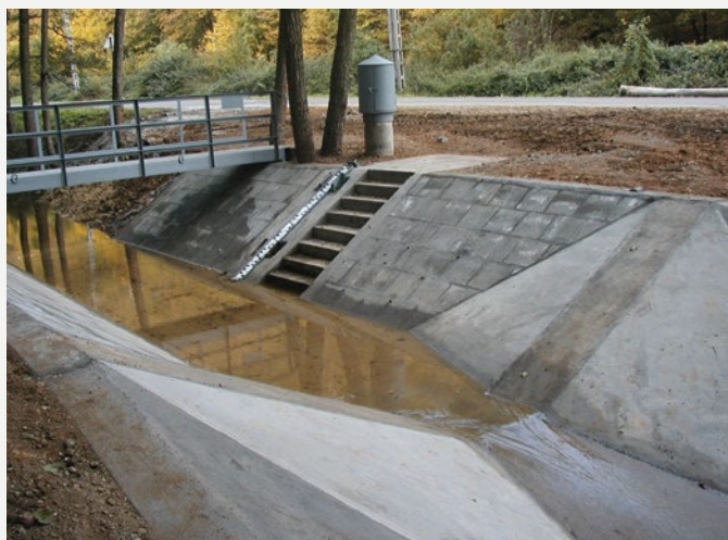
A Rák-patak 22,5 km 2 -es vízgyűjtőjének vízhozammérő műtárgya (©PI)
