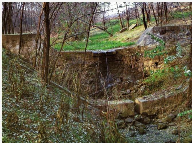
Vízmosáskötő kőgát vízládás utófenékkal (©RJ)
