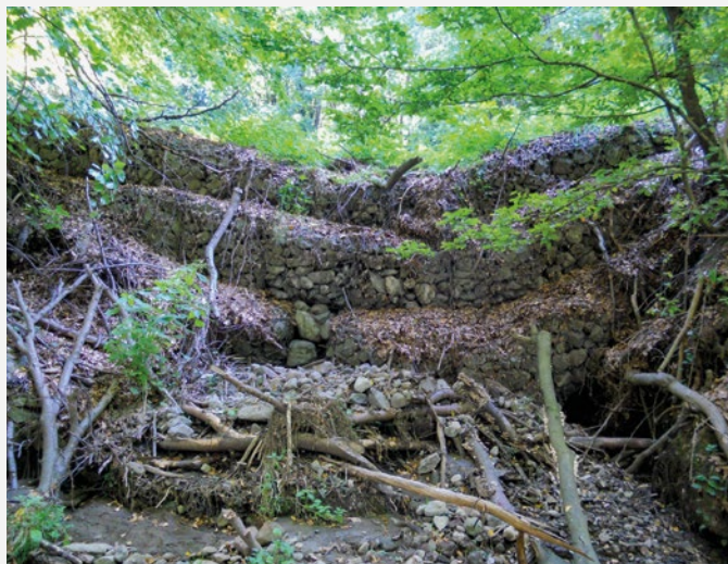
Nagy méretű gabion-gát az Apátkúti-völgyben (©KB)
