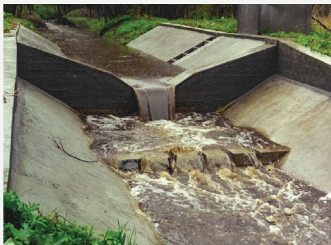
A Rák-patak 6 km 2 -es vízgyűjtőjének vízhozammérő műtárgya (©KuM)
