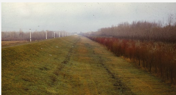
Az árvízvédelmi töltés védelmét szolgáló hullámtéri véderdő a szabadon tartandó sávval (©RJ)
