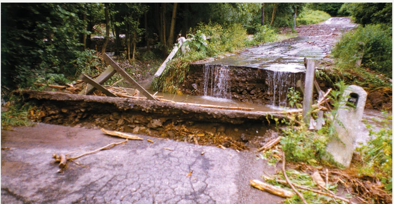
A Kemence-patak által elmosott, lerombolt erdészeti kishíd (©KuM)
