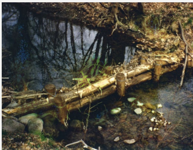
Rúdfából kialakított kis fenékgát a Bükkös-patak felső szakaszán (©BCS)
