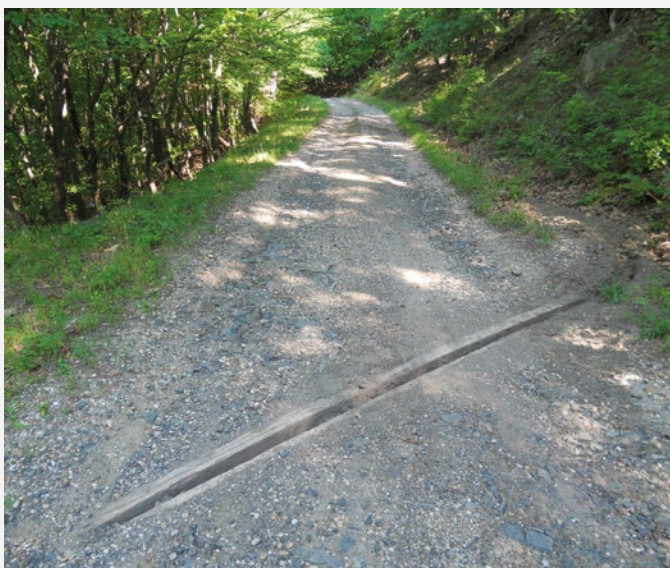
Keréknyomokban folyó vizet kivezető vízterelő (©KB)
