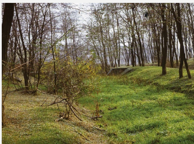
Vízmosáskötő kőgát feltöltődött, széles, kis hosszúságú, s a vegetáció által is „birtokba vett” gátudvara (©RJ)
