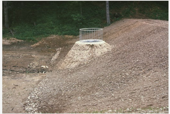
A Tacsi-árok közjóléti tavát védő hordalékfogó kistó még feltöltetlen állapotban (©RJ)
